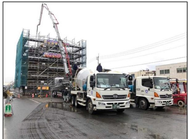
橋脚部 コンクリート打設状況
