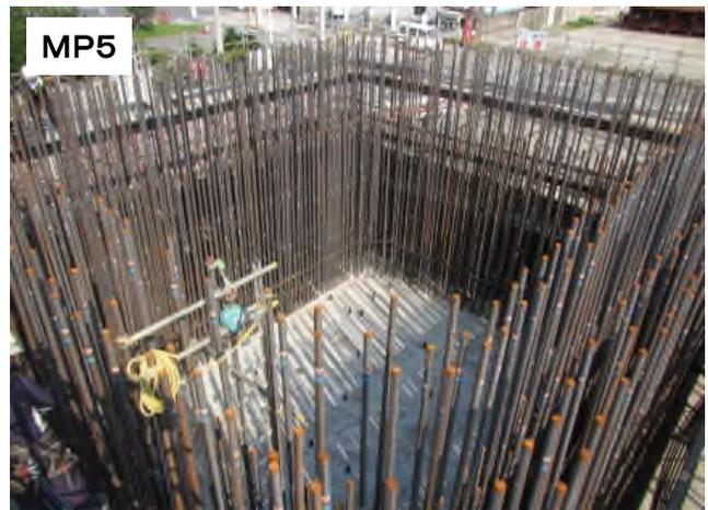
橋脚柱筋(D51)配筋状況
