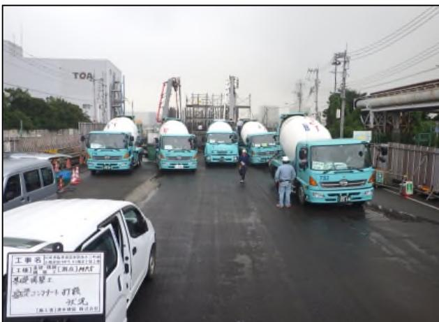
コンクリート打設時のミキサー車配置状況
