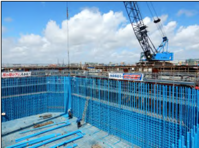
<R1.8> 橋脚鉄筋を組み立てています
