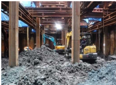
井筒内掘削 令和元年5月
