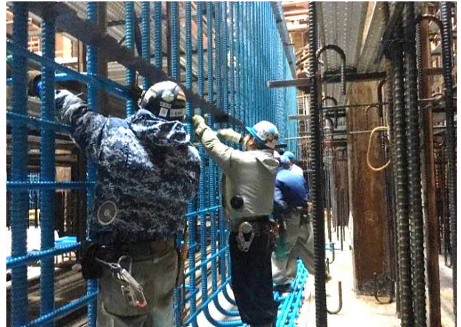
頂版内に含まれる橋脚部のエポキシ樹脂塗装鉄筋を組み立てている状況です。
