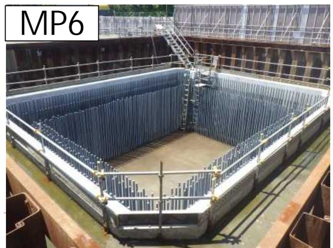
MP5・MP6ともに橋脚基礎部はコンクリートを14層に分けて施工する計画で、前回工事で13層までコンクリート打設が終了しています。
