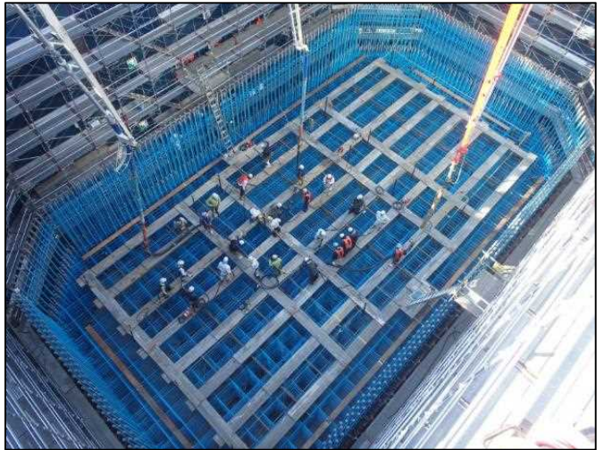
<令和1.5> 橋脚のコンクリートを打設しています
