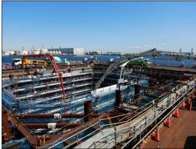
<令和1.5> 橋脚のコンクリートを打設しています
