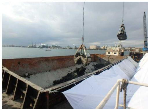
掘削した土砂を土運船に積込み、運搬している状況です。
