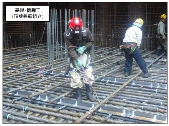
頂版コンクリートの 鉄筋を組み立てて いる状況です。
