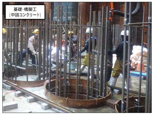
隔壁杭の杭頭部にコンクリートを打設している状況です。
