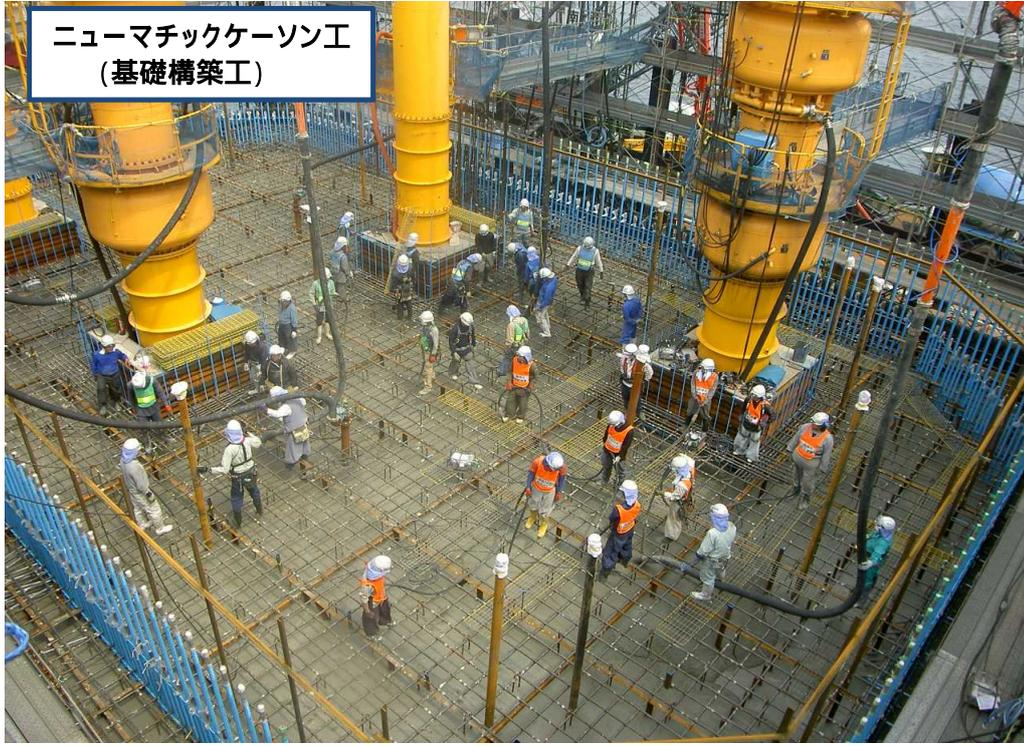
基礎構築底版(第13ロット)のコンクリート打設を行っている状況です。
