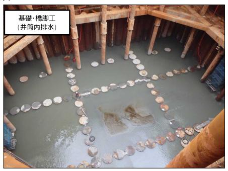
水中ポンプを 使って、井筒の 中の水を排水し ています。
