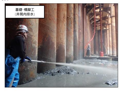
基礎のコンクリートを施工する前に井筒の中を清掃しています。
