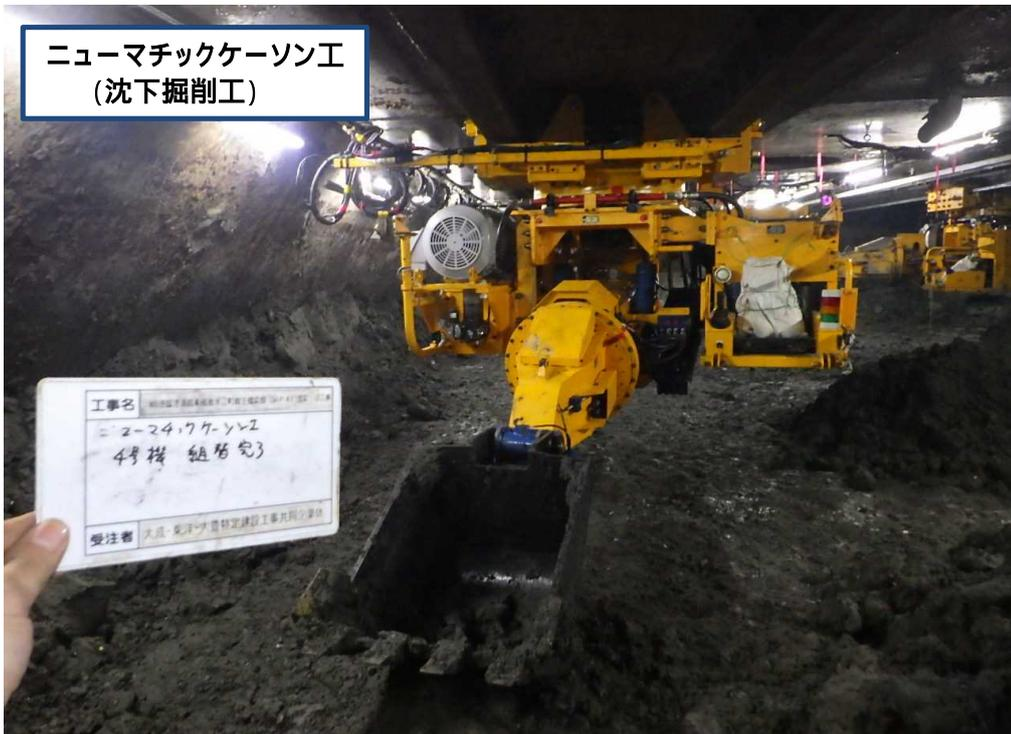
ケーソン函内の掘削機械を組立てている状況です。
