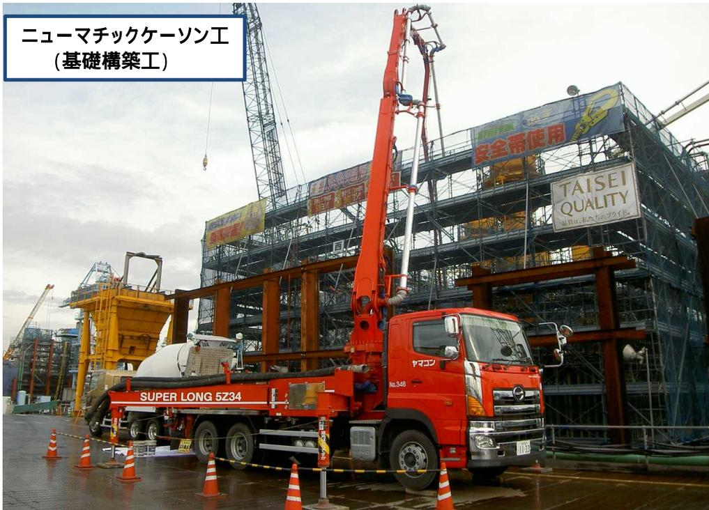
躯体構築(第9 - 2ロット)のコンクリート打設を行っている状況です。
