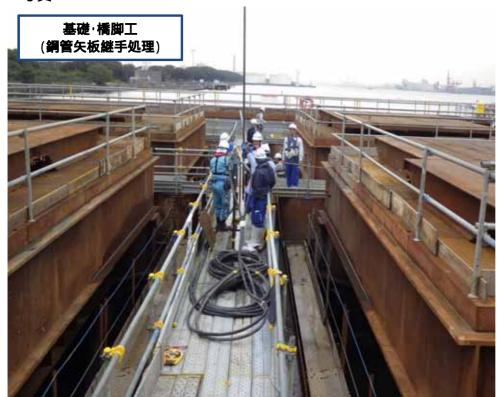
鋼管矢板間の継手にモルタルを 注入し、鋼管矢 板井筒内を密閉 構造にします。
