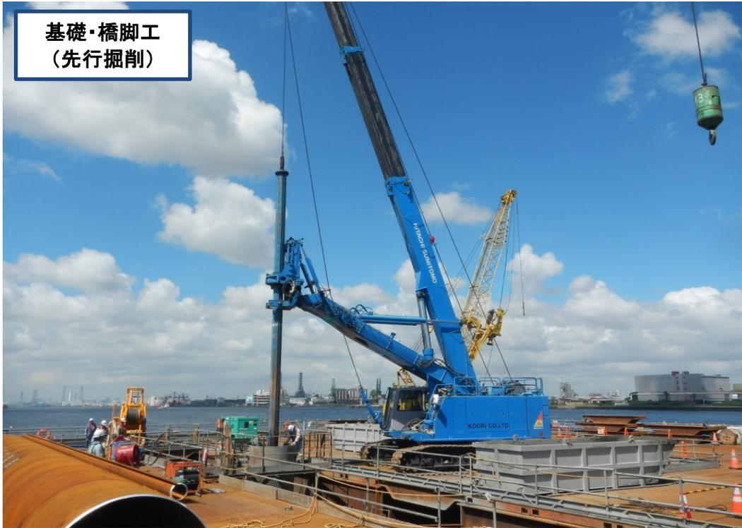
鋼管矢板打設のため先行掘削を行っている状況です。
