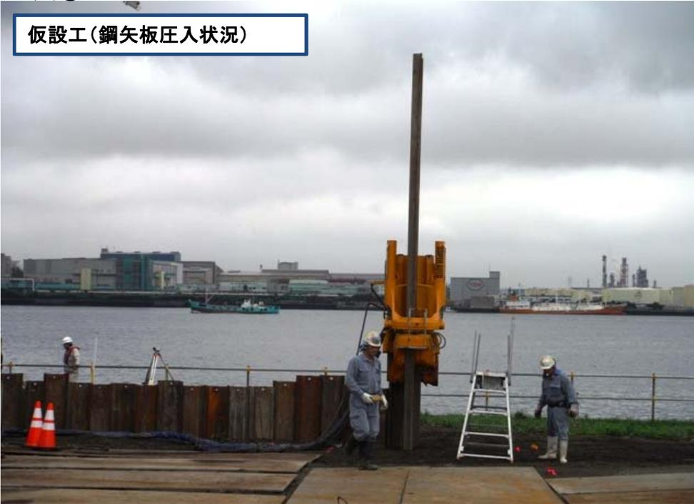
写真は、躯体構築エリアに鋼矢板を圧入している状況です。
