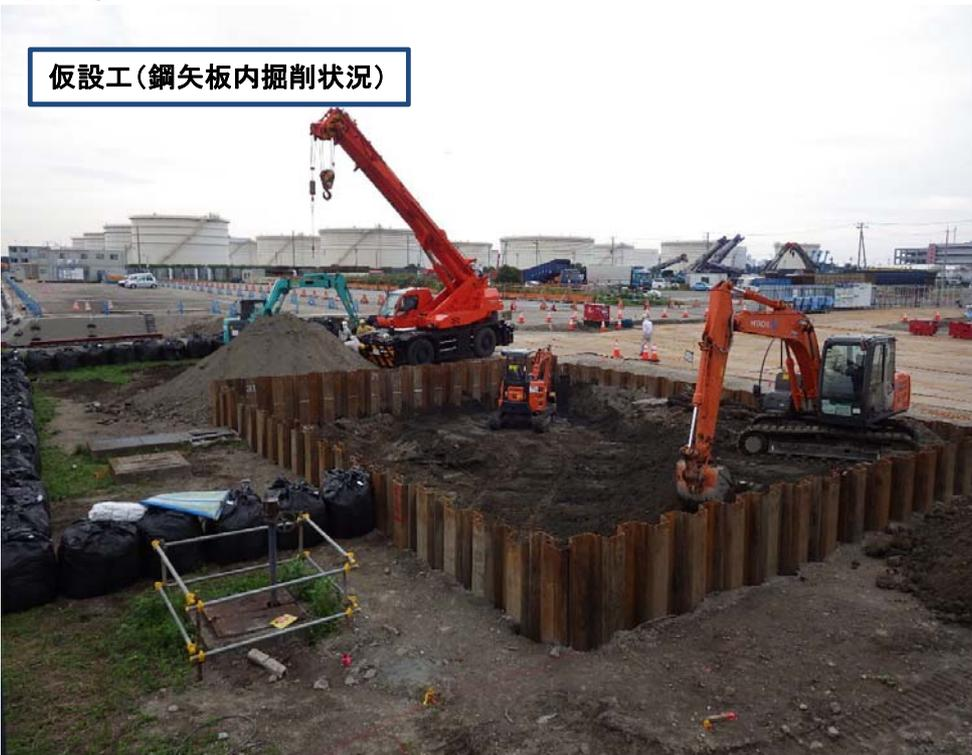
写真は、鋼矢板内の地盤を掘削している状況です。
