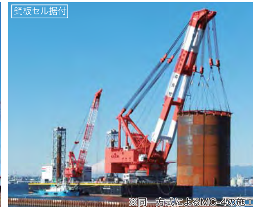
世界最大の大口径鋼板セル【直径24.5m、高さ32m(8階建てのビルの高さに相当)】
