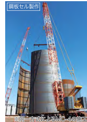
世界最大の大口径鋼板セル【直径24.5m、高さ32m(8階建てのビルの高さに相当)】
