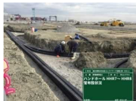
電線管敷設 令和2年3月
