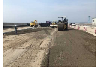
上層路盤敷均し・転圧状況
