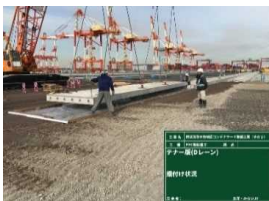
PPC版据付 令和2年2月
