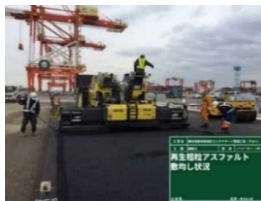
アスファルト舗装 令和2年2月
