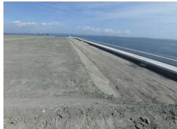
着工前は、埋立後に地盤を固めるための載荷盛土を行っている段階でした。
