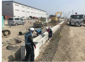
排水構造物据付状況
