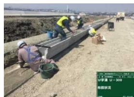
排水構造物(側溝)据付 令和2年4月
