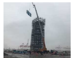
照明鉄塔架設 令和2年6月
