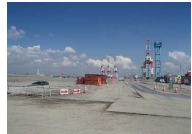
着工前は、埋立後に地盤を固めるための載荷盛土を行っている段階でした。
