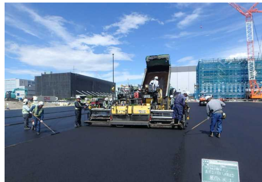
アスファルト舗装工 表層敷均し状況 令和2年9月
