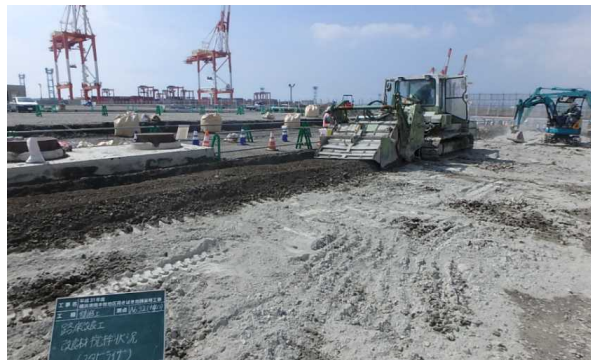
路床改良工 改良材攪拌状況 令和2年8月
