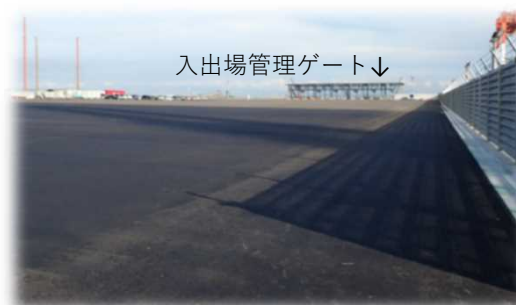
ゲートに入るための待機場エリア
