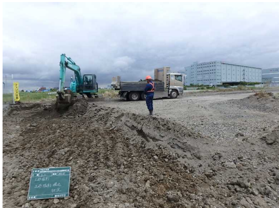
土工 土砂掘削・整地状況 令和2年6月
