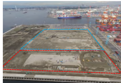
R1.9.24 舗装工_路盤
