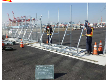
門扉設置状況 令和2年2月
