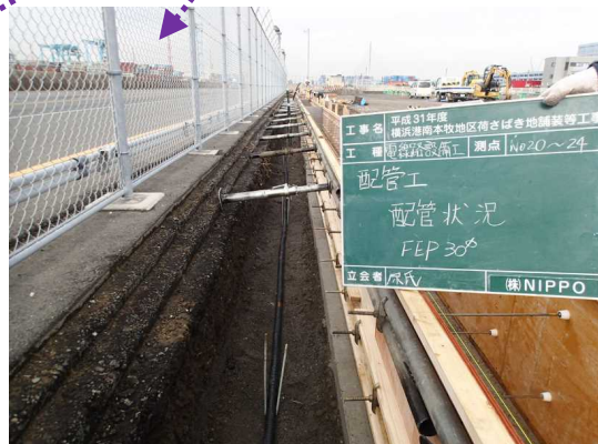
配管工 配管状況 令和2年1月
