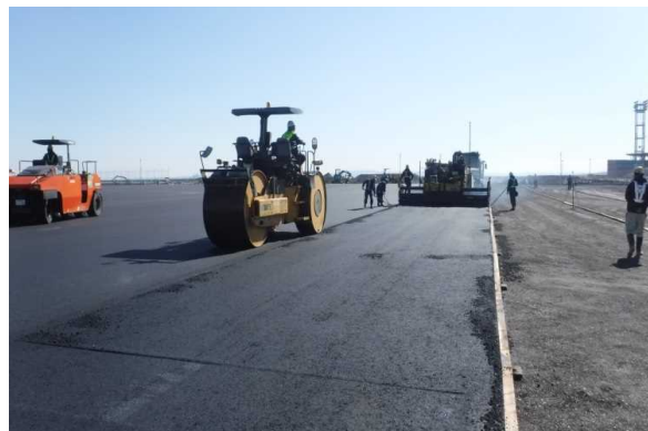
舗装工 アスファルト舗装(1)基層 令和2年2月
