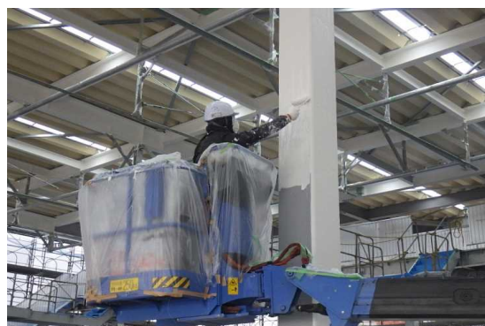
耐火塗装工 令和2年2月
