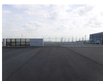
工事了 令和2年2月
