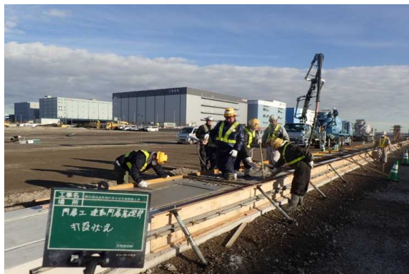
付帯工 門扉設置(基礎コンクリート打設) 令和2年1月
