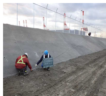
モルタル吹付出来形確認 令和2年1月
