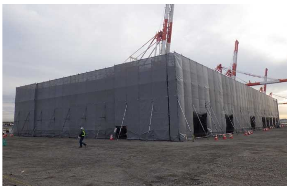
足場組立完了 令和2年1月
