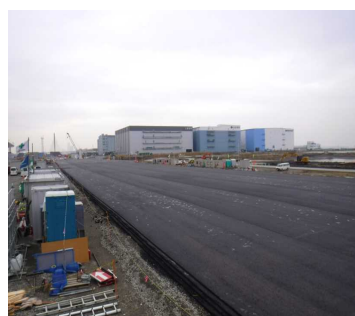
舗装完了 令和元年12月
