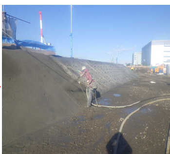
モルタル吹付状況 令和2年1月
