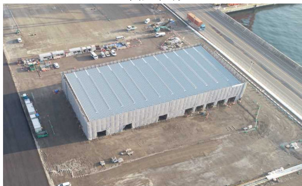
屋根工事了 令和2年1月
