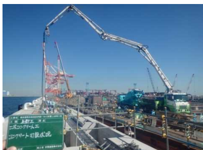
二次コン打設
