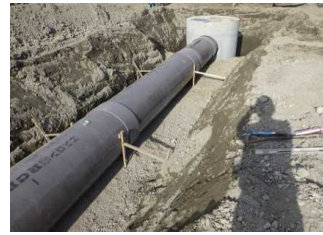
FRPM管敷設完了
