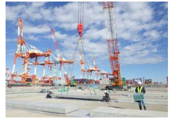
PPC版据付状況
