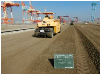
路盤転圧状況
