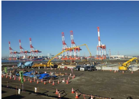
ゲート基礎 コンクリート打設
