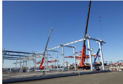
クレーンと高所作業車による鉄骨施工
