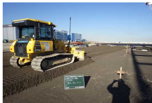
入出場ゲート周りの舗装工 下層路盤施工
