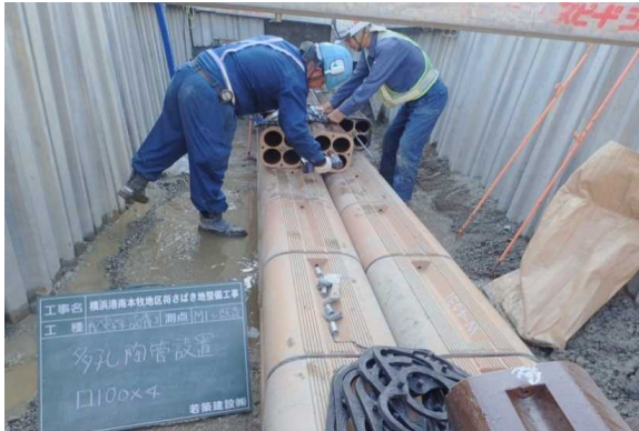
配電線設備工 多孔陶管設置
