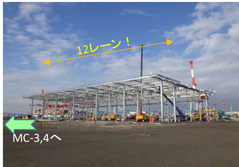
ゲート 鉄骨建て方 (全景)
