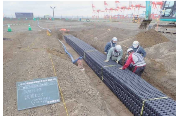
配電線設備工 角型FEP管設置
