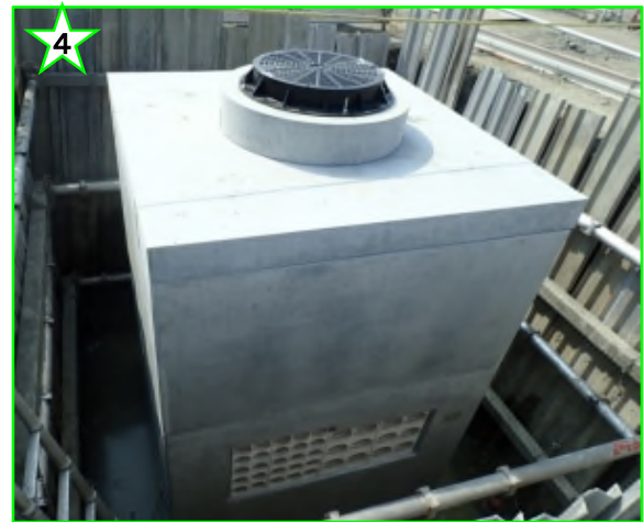
コンテナヤードに必要な多数の電線を配電する設備(ハンドホール)を設置しました。
