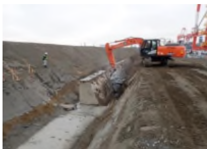
中仕切り護岸撤去 平成31年 3月
