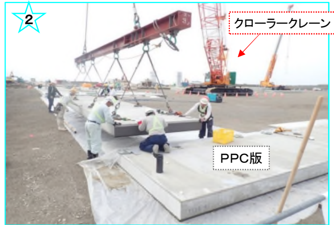
大きなコンテナを運ぶクレーンが走行する場所に、クローラークレーンで強固なPPC版を設置しています。
