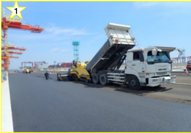
本船からの荷卸しの荷役エリア(エプロン)に、アスファルトを舗設しています。
