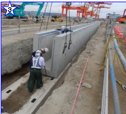
広い面積に降った雨を排水する為の排水設備(自由勾配側溝)を設置しています。
