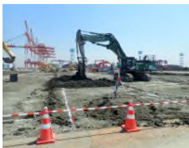
地盤改良 令和元年 6月
