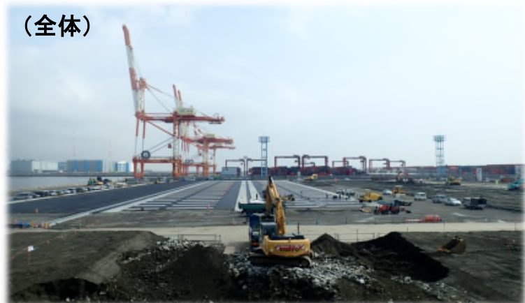
PPC版(白色)間へのアスファルト舗装(黒色)が完了すれば、コンテナヤード整備は完了します。
