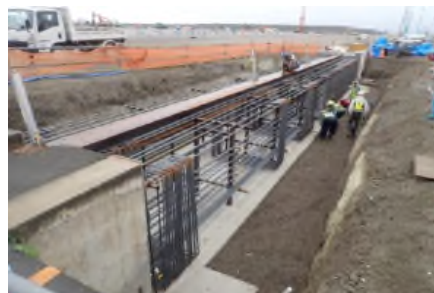
クレーンレール基礎 鉄筋組立 令和元年 8月
