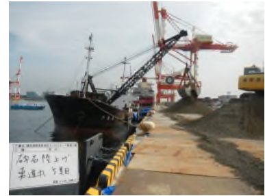
ガット船による砕石荷揚げ状況
