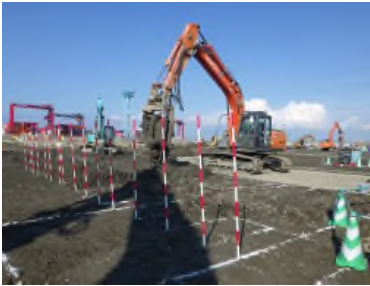
路床改良工状況
