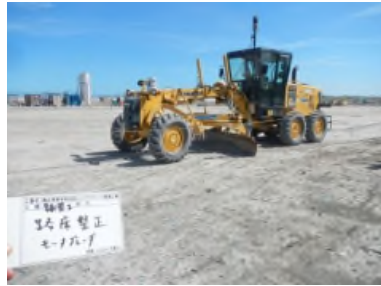
路床整正状況
