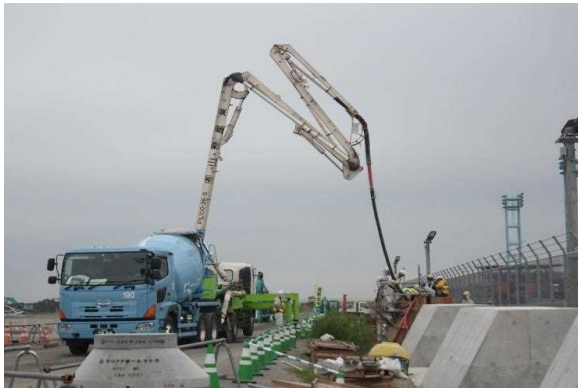
擁壁工 コンクリート打設 令和元年8月
