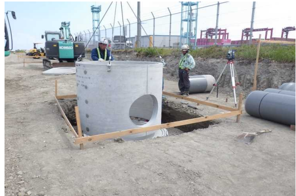
排水構造物工 マンホール据付 令和元年8月
