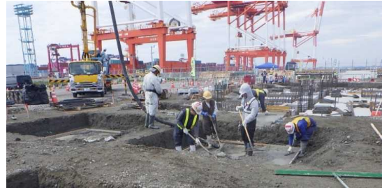
均しコンクリート 打設状況
