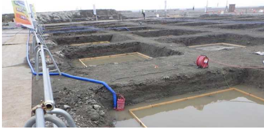
前夜の雨により、コンクリートの打設予定箇所に水が！ 打設前に水を排水しています。
