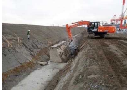
中仕切り護岸撤去 平成31年 3月
