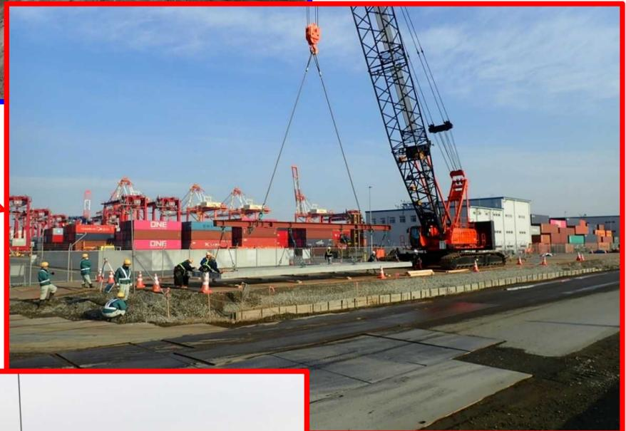
PPC版は、最大重量約22tあるので、120t吊クローラークレーンで荷卸します。
