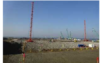
プラスチックボードドレーン打設
