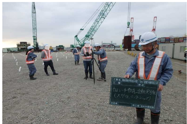
学生によるGPS測量機を用いた位置出し測量の実習
