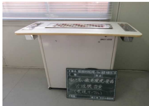
分煙対策装置の設置
