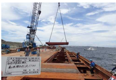
海側作業構台 撤去 平成30年 9月
