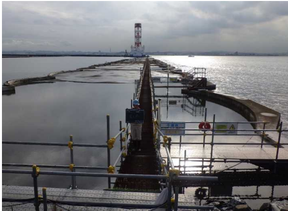
着工前(平成29年10月)
