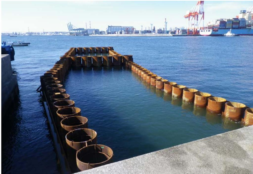
写真② 既設ケーソンと鋼管矢板の間に水中型枠を設置している状況です。
