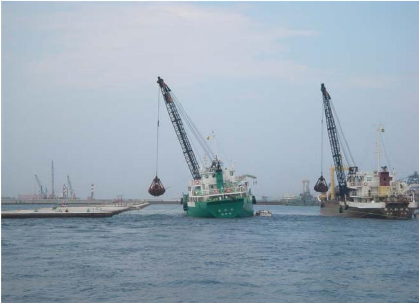
ケーソンの基礎となる捨石をガット船で-20mの深さまで投入してマウンドを築造します。
