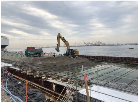
裏埋材投入状況
