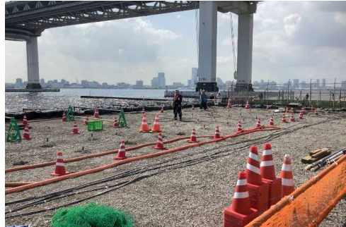
薬液注入工 注入状況
