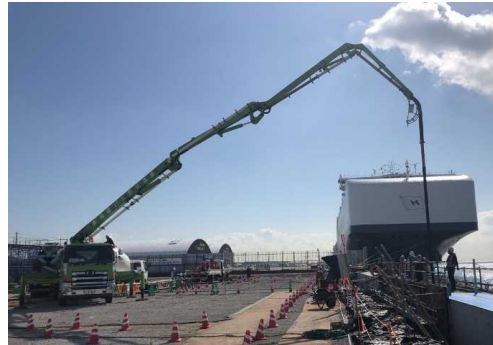
上部コンクリート打設状況
