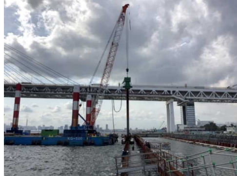
鋼管矢板打設状況
