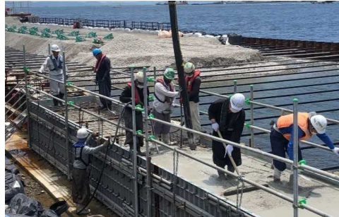
頂部コンクリート打設状況
