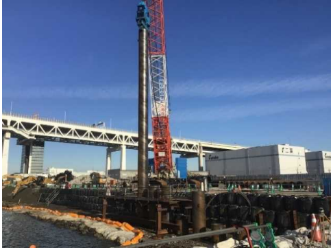
控鋼杭打設状況
