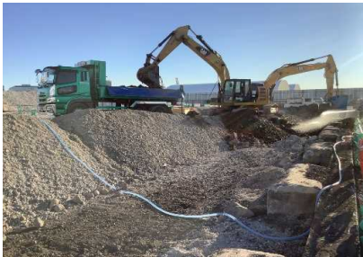
裏込石撤去運搬 令和 2年12月～令和 3年 1月
