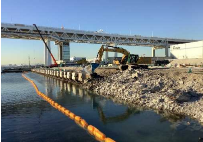
栈橋式上部工撤去状況 令和 2年12月～令和 3年 1月
