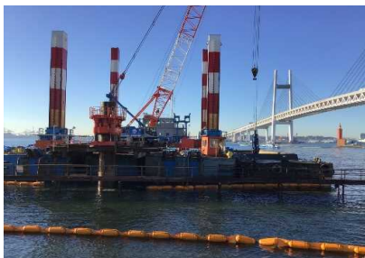
先行削孔・置換状況 令和 3年 1月
