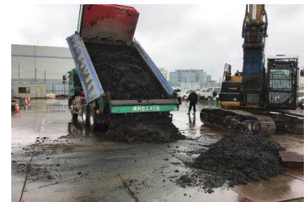
支障物場内仮置 令和 2年11月
