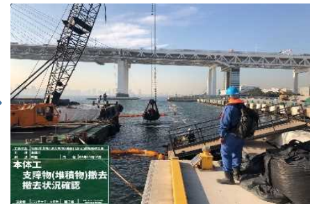
本体工（支障物撤去） 令和2年11月
