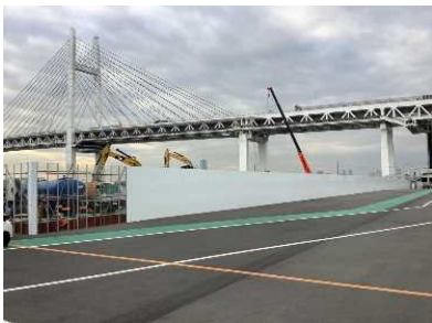
仮設工（仮囲い設置） 令和2年11月
