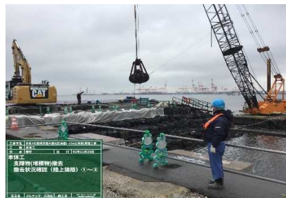
支障物陸上揚陸状況 令和 2年11月
