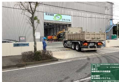
支障物処分先運搬状況 令和 2年12月
