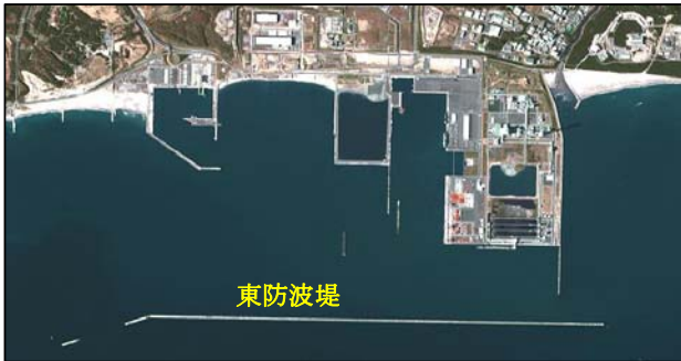
△茨城港(常陸那珂港区)東防波堤位置
