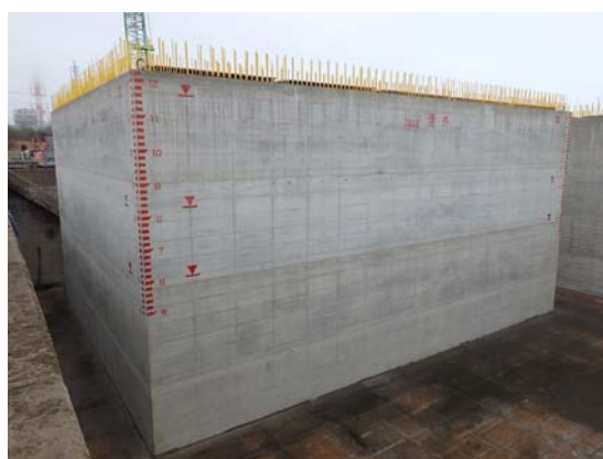
ケーソン製作完成
