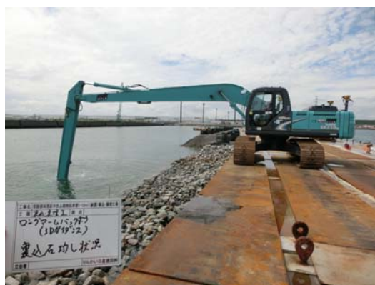
裏込石均し状況
