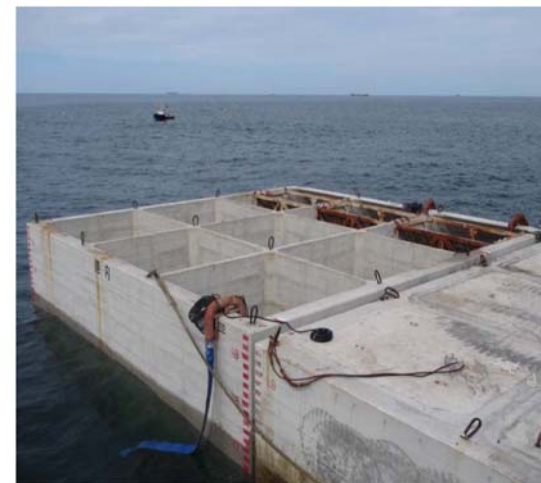
③ケーソン据付完了
