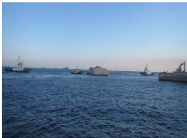
①ケーソン曳航状況
