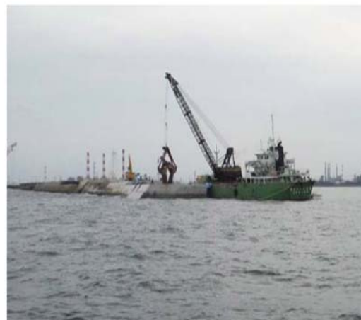
④中詰材投入状況
