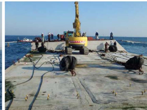
③ケーソン据付状況
