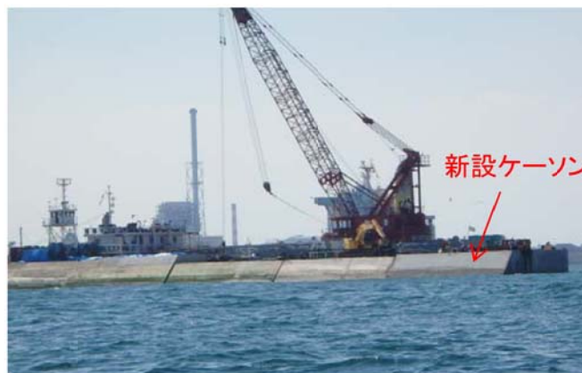
④ケーソン据付完了
