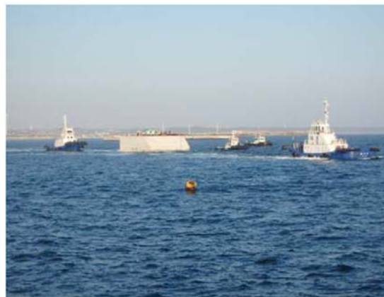
②ケーソン曳航状況
