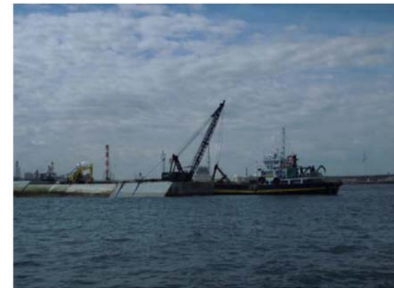
⑤中詰材投入状況
