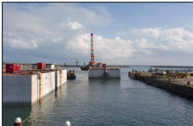
ケーソンの大きさによってはケーソンヤードのなかで工事が完了するものもありますが、ケーソンヤード内では完成できず、海上打ち継ぎ場へ移動して更にコンクリートを打ち継いで所定の大きさにして完成させる場合があります。
