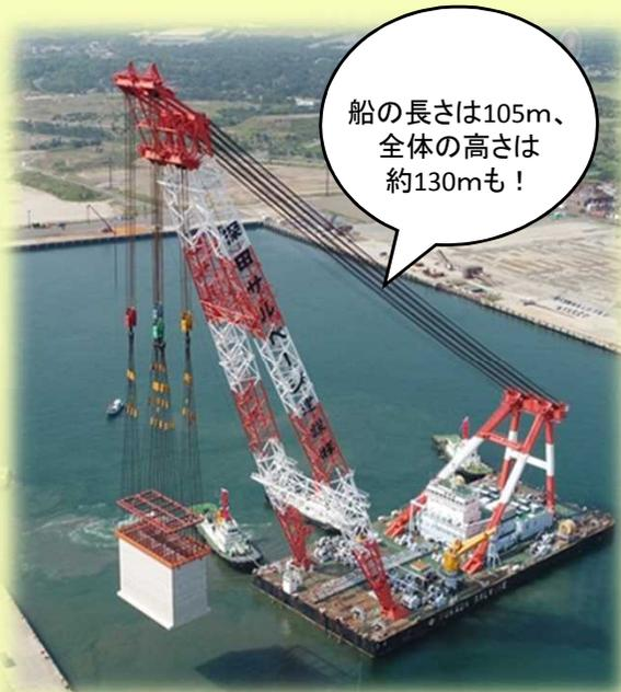
陸上で作られたケーソンを大きな起重機船で海中へ。波の影響を受けにくい防波堤の内側へ仮置きします。
