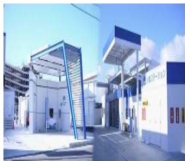
水素ステーション
