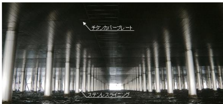
飛沫帯等の厳しい腐食環境に対する防食仕様 (ステンレスライニングとチタンカバープレート)
