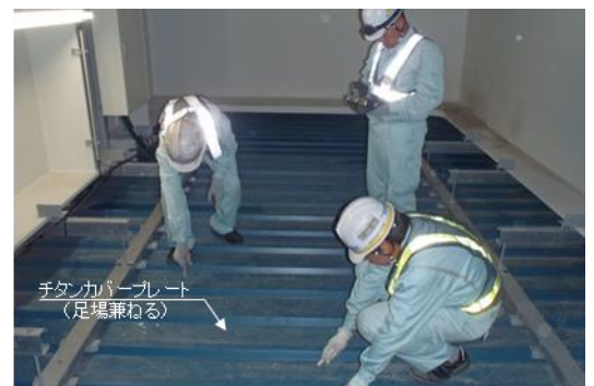
栈橋上部点検状況 (足場兼ねたチタンカバープレート)
