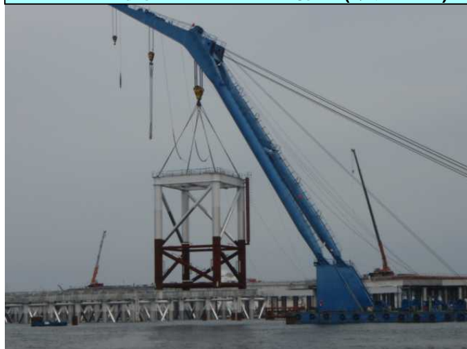
H21.6.17 最終ジャケットの据付(場周道路)
