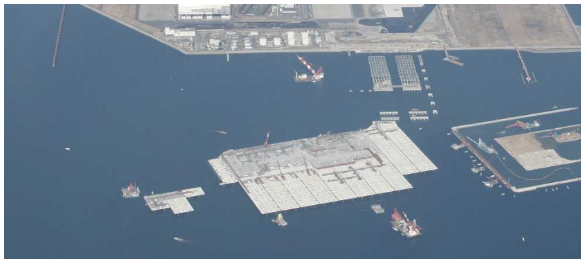
写真； 棧橋部・連絡誘導路部の状況(H21. 2. 6 撮影)
