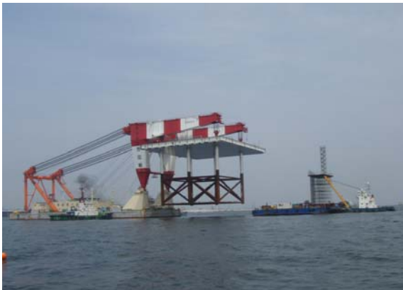
写真；棧橋部ジャケット130基目据付状況(H21. 4. 12撮影)
