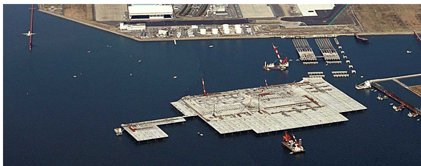
写真； 棧橋部・連絡誘導路部の状況(H21. 3.15 撮影)
