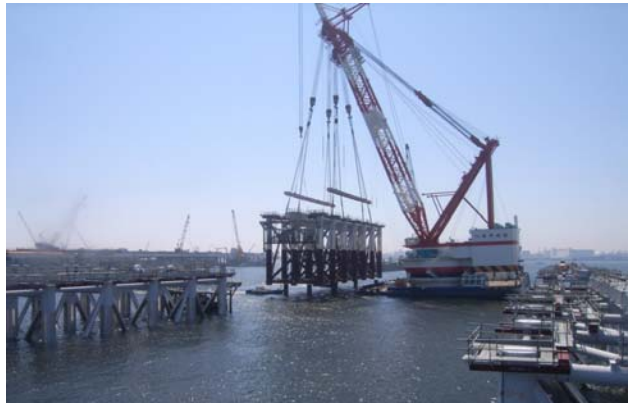
写真；連絡誘導路部ジャケット30基目据付状況(H21. 4. 10撮影)
