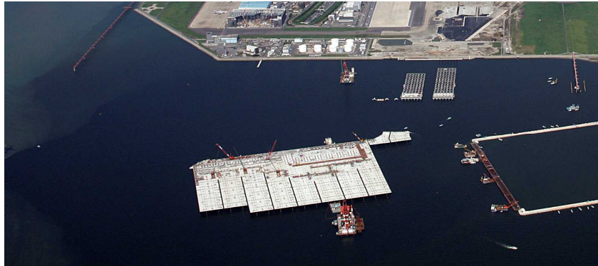
写真； 棧橋部・連絡誘導路部の状況(H20. 9.24 撮影)
