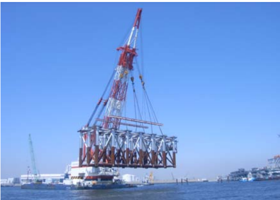
写真；連絡誘導路部ジャケット30基目据付状況(H21. 4. 10撮影)
