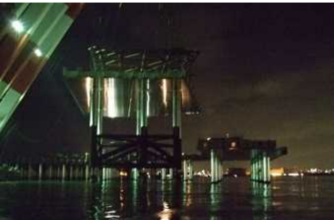
A-15 ジャケット据え付け状況(監督船より撮影)
