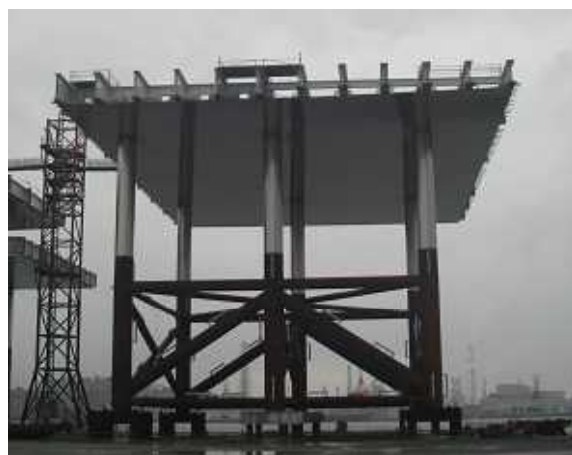
標準部ジャケット仮置き状況
