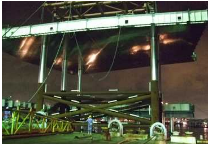
A-15 ジャケット据え付け状況(ジャケット上より撮影)
