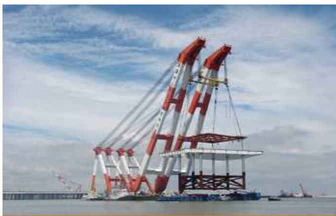
起重機船「武蔵」による吊り上げ状況（60基目）
