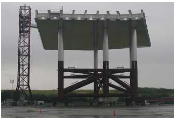
60基目 異形部ジャケット仮置き状況
