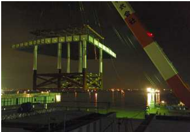
A-15 ジャケット据え付け状況(ジャケット上より撮影)
