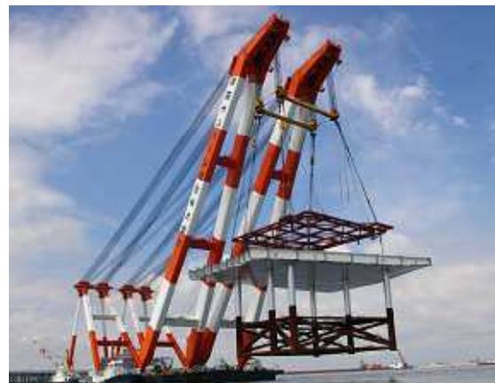
起重機船「武蔵」による吊り上げ状況（60基目）
