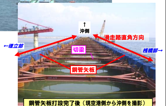
鋼管矢板打設完了後 (現空港側から沖側を撮影)
