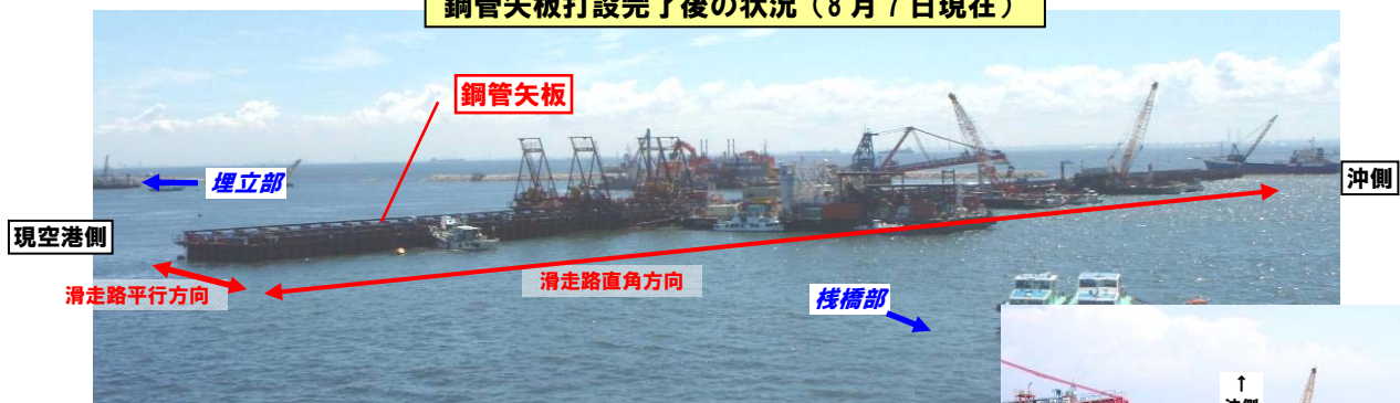
鋼管矢板打設完了後の状況 (8月7日現在)
