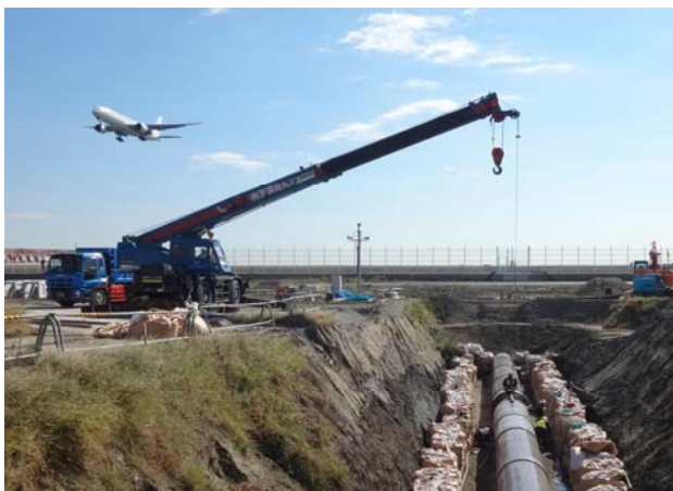
排水管敷設の施工状況
