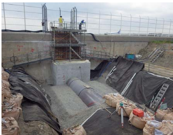
護岸吐出部の施工状況
