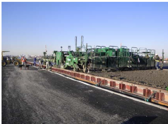
【コンクリート舗装打設状況】
